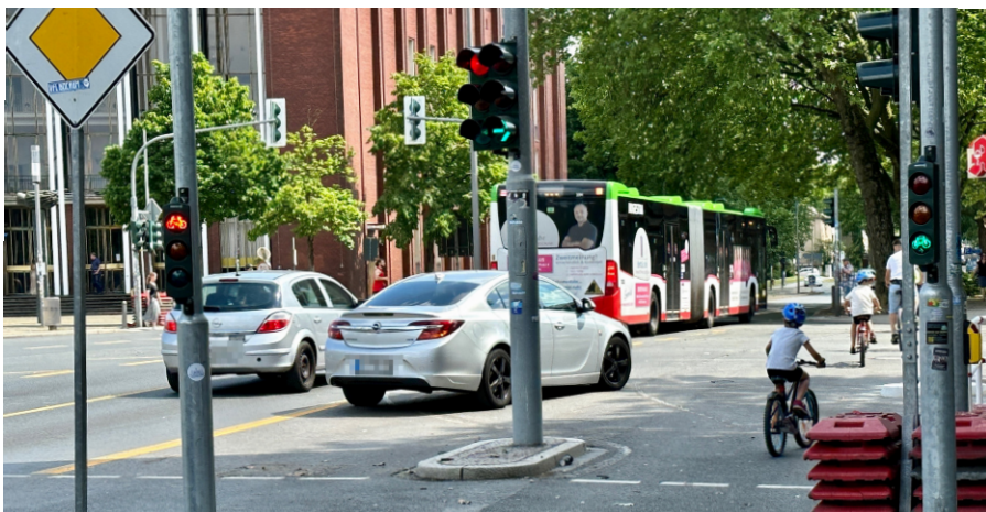
Neue Abbiegesituation an der Schauspielhauskreuzung
