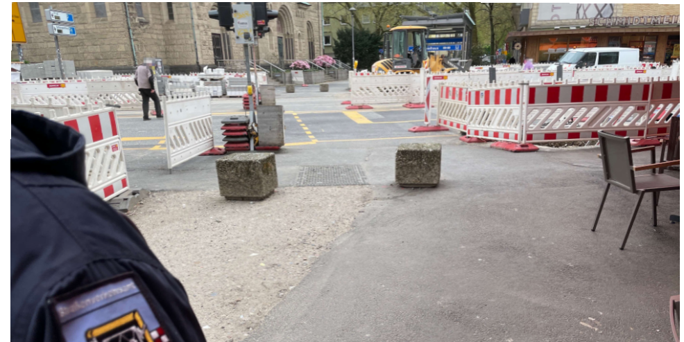
Blick auf den Überweg über die Hattinger Straße - mit den wieder errichteten Betonquadern, die die illegale Befahrung verhindern sollen
