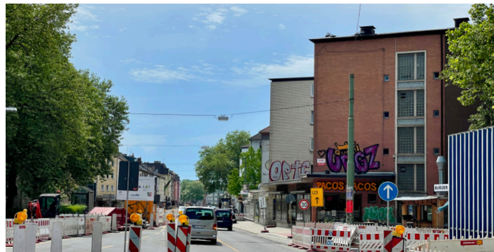
Baumaßnahme Hattinger Straße: eine der Umleitungssituationen in 2022
