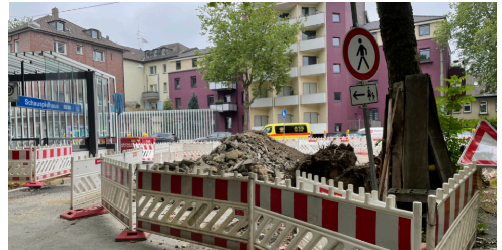
Bild von der Baumaßnahme an der Hattinger Straße mit Umleitungen für den Fußverkehr (aus dem Juni 2021)
